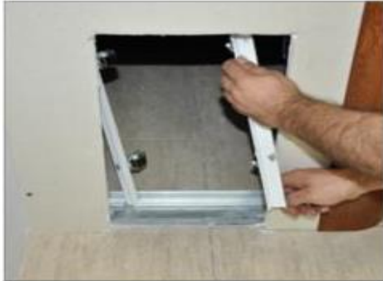
KAPAK YERİNE TAKILDIKTAN BİR GÜN SONRA DİĞER KISIMLARIN SERAMİĞİ YAPILIR. AFTER MOUNTING THE COVER, OTHER SURFACES ARE COATED WITH CERAMIC TILES.
