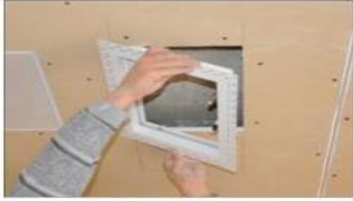
DIŞ ÇERÇEVE YERLEŞİMİ ASSEMBLY OF OUTER FRAME
