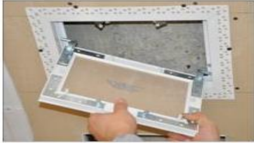
İÇ KAPAĞI SÖKÜP TAKABİLMEK İÇİN YAN ÇEVİRMEK GEREKMEKTEDİR TURN THE COVER TO ONE SIDE FOR
